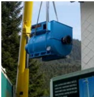
Au mois de juin, une opération peu courante a été réalisée à la centrale hydroélectrique de Blanchemer. En effet, l'alternateur de la centrale de La Lande devant être contrôlé en usine (opération réalisée tous les 20 ans environ), a été sorti de la centrale avant d'être transporté à l'usine Lorelec en banlieue nancéienne.
