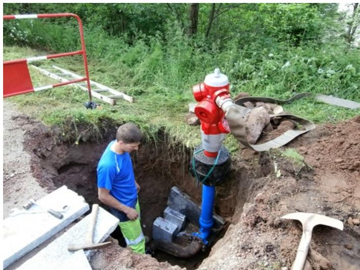
▲ Remplacement d'un nœud de vannes sur le réseau
